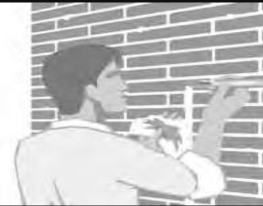
Boya uygulamasında istenilen renk tonuna ulaşmak için boyayı hafif katmanlar halinde uygulayın , böylece birleşim yerlerini görsel olarak kaybetmiş olacaksınız.
