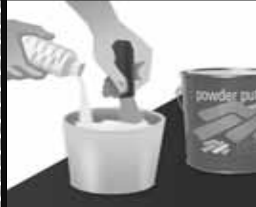
Birleşim yerlerini kapatacak malzemeyi hazırlayın.
